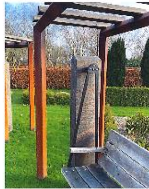
Detalje ved sæde (granit) og gænge (eg)
